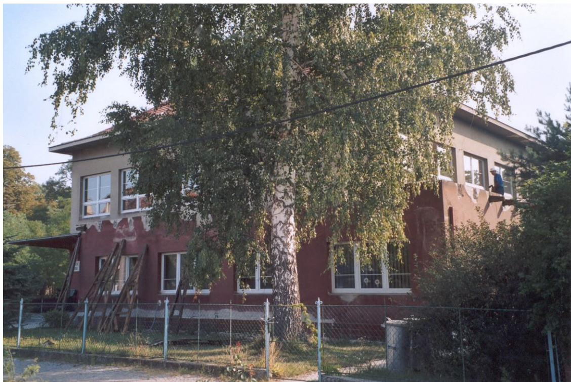
Základní škola v Hoříně rok po povodni, dne 24. července 2003
